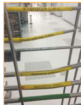
Маркировка трубопроводов с химикатами и сверхчистыми газами
