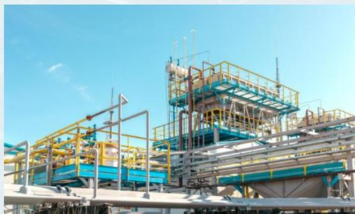
Компрессорная установка блочно-модульного исполнения
