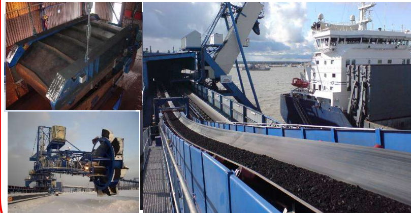
Вагонопрокидыватель, тепляк, магнитный сепаратор, конвейерные линии
